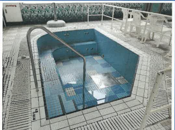
●屋内ジャグジー周り
